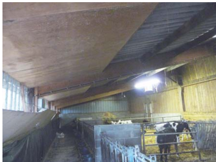
Entrée d'air protégée par un déflecteur haut et bas
