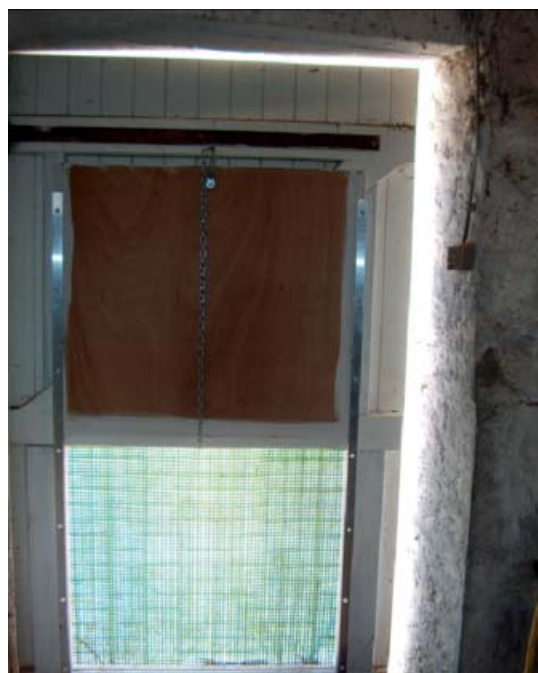
Entrées d'air en partie basse d'une porte
